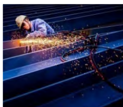
Строительство и монтаж
